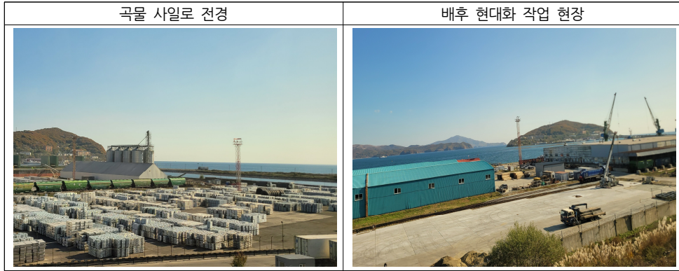
[그림 4] 자루비노항 곡물 사일로와 배후 현대화 작업 현장
