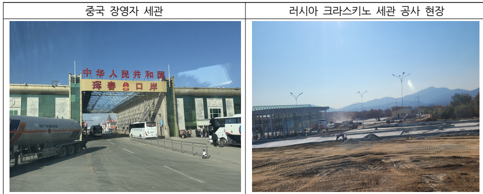
[그림 3] 중국 장영자 세관 전경과 러시아 크라스키노 세관 공사 현장
